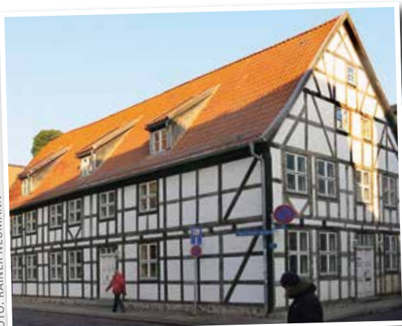
Das Pfarrwitwenhaus vor der letzten Sanierung.
